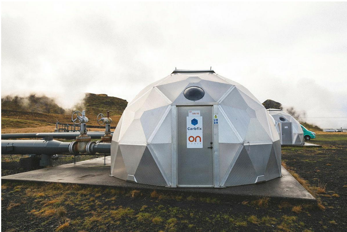
Mynd 5.2: Niðurdælingarhola HN-16 sem er CO 2 niðurdælingarhola Hellisheiðarvirkjunar.
